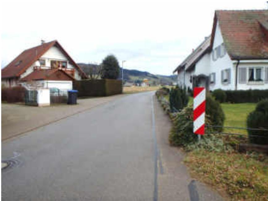
Es wird empfohlen, die Engstelle baulich zu einer echten Engstelle umzubauen. Fahrzeugbegegnungen sollen auf diesem Abschnitt dann nicht mehr möglich sein, auch nicht für Pkw. Mehrere Entwürfe für eine mögliche bauliche Ausführung wurden bereits erstellt, auch Grunderwerb zur Ausbildung von Wartebereichen vor der Engstelle ist möglich. Die endgültige bauliche Ausbildung ist abhängig von weiteren Randbedingungen (Umfang des Grunderwerbs, mögliche Erschließung weiterer Grundstücke).
